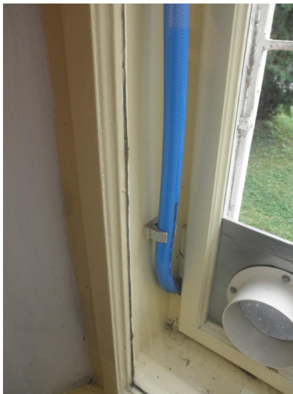
Odvod kondenzátu skrz rám okna – okno č.13
